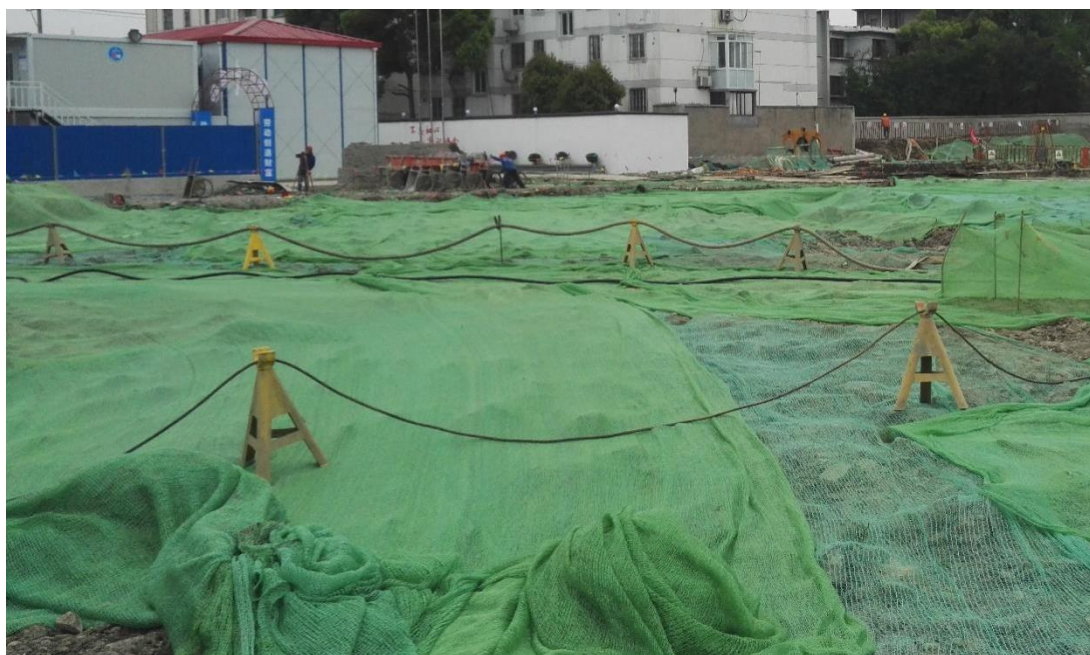
图 6.3-3 三脚架架空电缆
