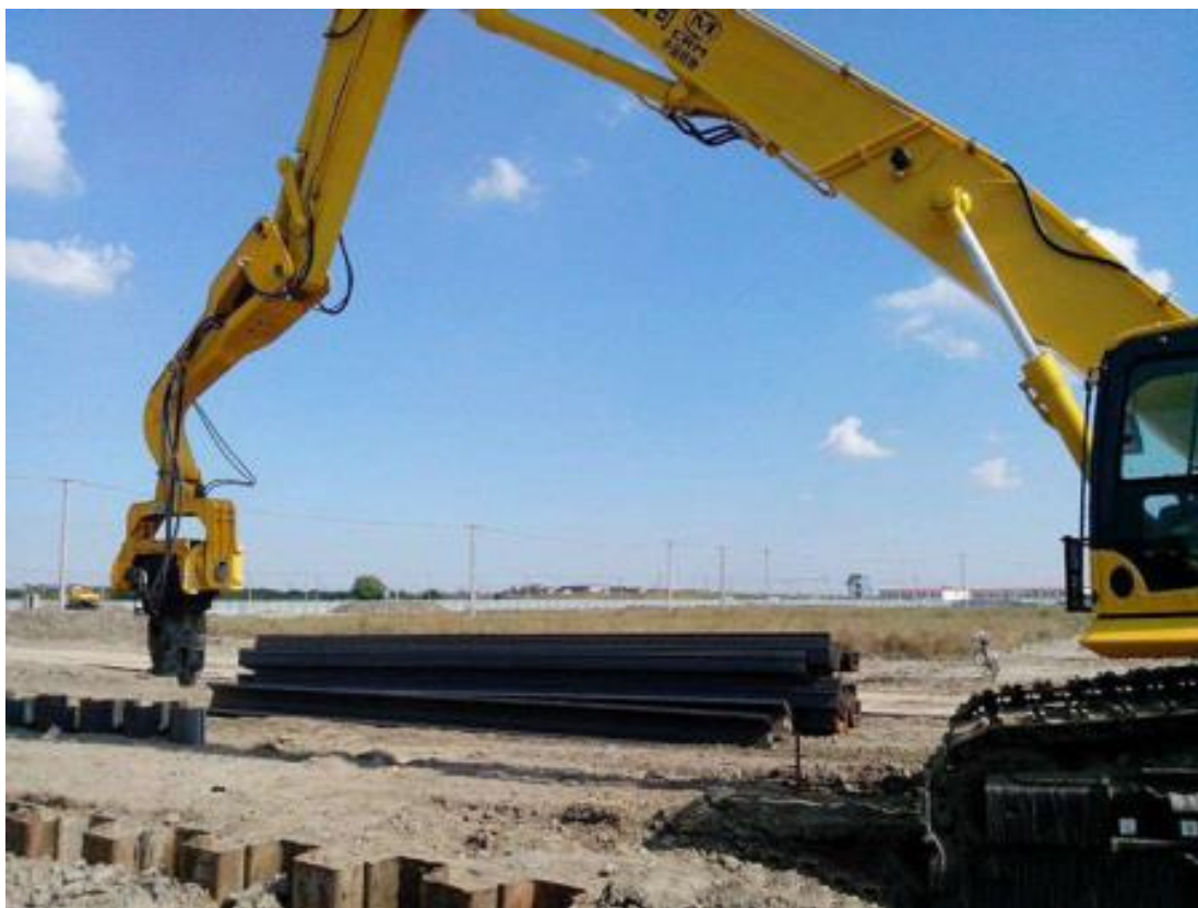
图 6.6-1 拉森钢板桩打设
